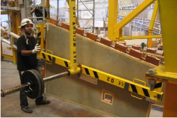
図 8: TGC を吊り具で設置する作業。
