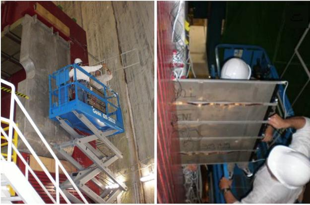
図6-5 シザースリフトと自作の専用ツールを使用してのインストール作業(この写真は垂直用モジュール)
