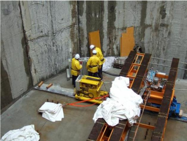
図 4-1 移動システムと架台
