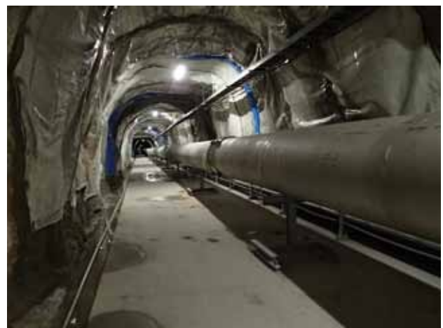
図 10. KAGRA 3km トンネル。
