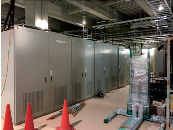
図 13: インストール後の QFR 用変換器
