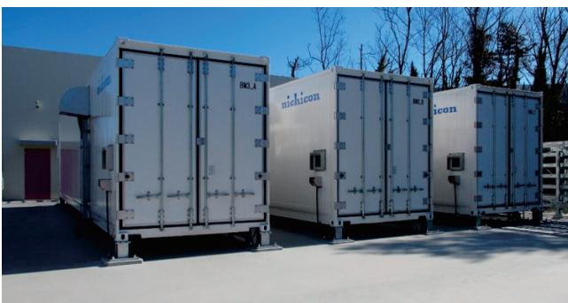
図 17: 偏向電磁石用変換器 1 台分のコンデンサバンク用コンテナ。最終的にはこの 6 倍の 18 本が必要。
