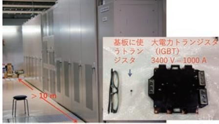
図 3: 電磁石用電力変換器とそれに使われているトランジスタの例
