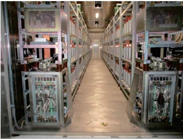
図 16: コンデンサバンクコンテナの内部。図 15 の回路 2つが左右にそれぞれ配置されている
