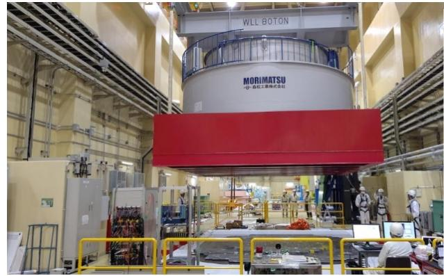
図 7: MLF3 階でのクレーンを使った検出器移動時の写真。一番下に見える矩形が第二防油堤、その上の円柱が第一防油堤。その上の円柱がステンレスタンク。
